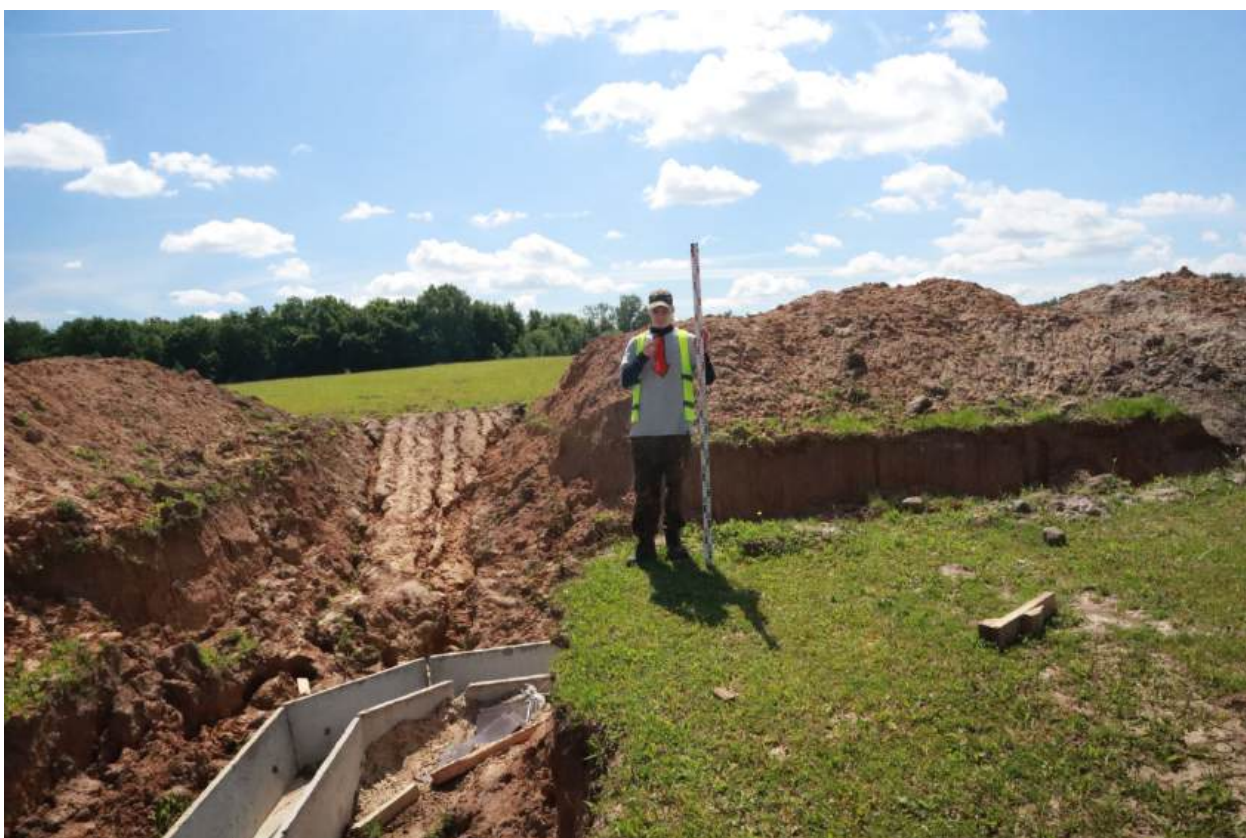
Рис. 30. Обеспечение сохранности ОКН федерального значения «Поселение Ольгинское» в г. Нижний Новгород. 2026 г. Участок проектирования. Точка фотофиксации 5. Вид с С.
