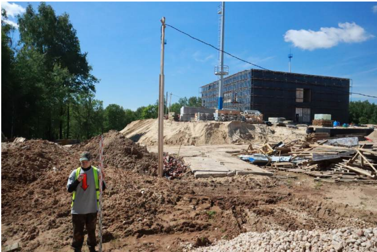
Рис. 21. Обеспечение сохранности ОКН федерального значения «Поселение Ольгинское» в г. Нижний Новгород. 2026 г. Участок проектирования. Точка фотофиксации 1. Вид с С.
